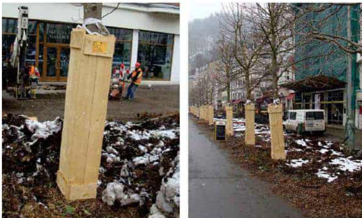
9 pav. Galima medžių kamienų apsauga vykdant darbus
