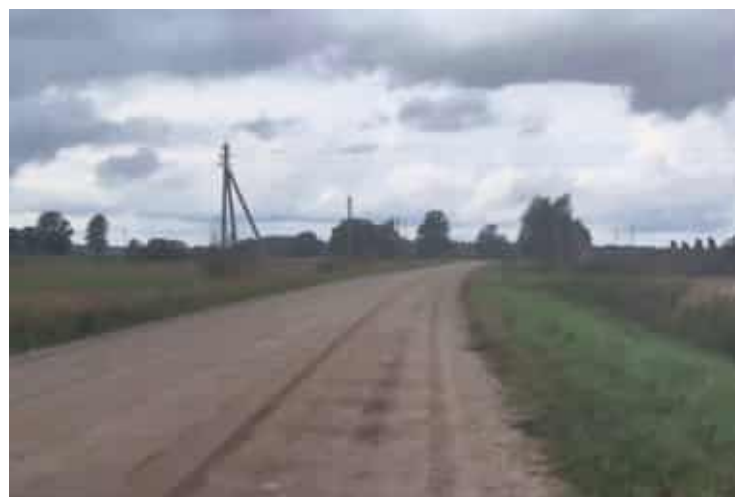
3 pav. Esama kelio būklė
